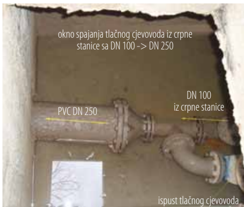
Ilustracija 5 Postojeće stanje opreme crpne stanice
