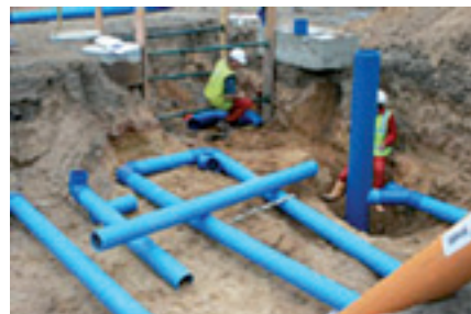
Ilustracija 3 Neki elementi izmjenjivača topline tlo - zrak pri polaganju
