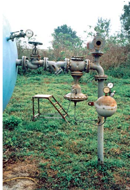
Ilustracija 4 Mjerno-regulacijska linija stlačenog zraka 15/4 bar
