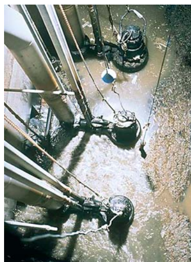
Ilustracija 1 Potopljene crpke u pogonu
